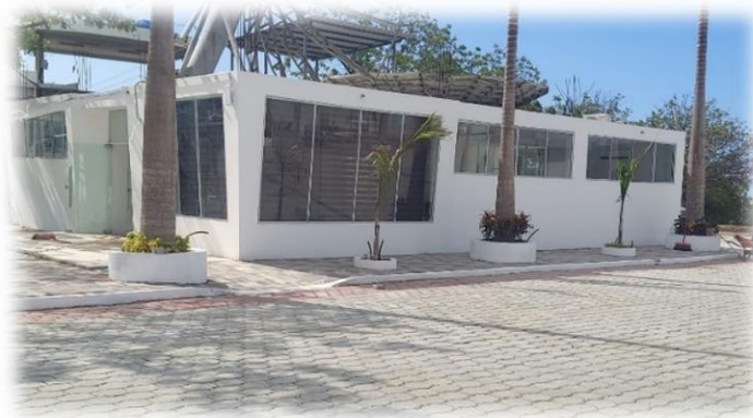
Gráfico 46: Construcción del Área Administrativa de Posgrado Uleam Matriz
