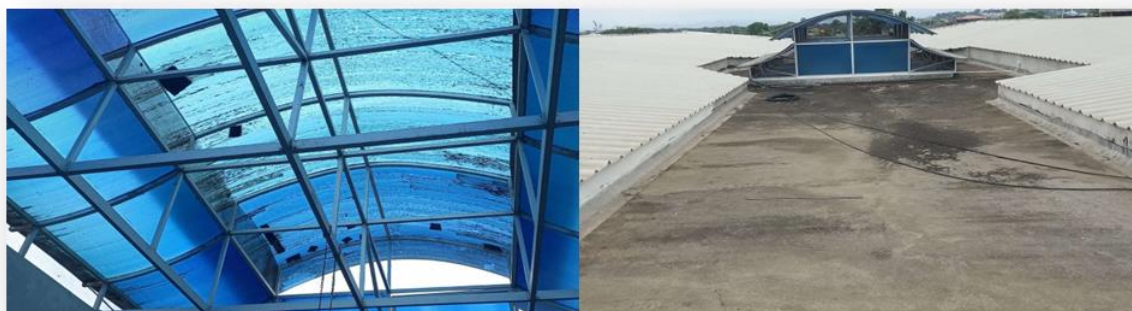
Gráfico 52: Cambio de policarbonato en el tragaluz e impermeabilización de la Extensión Tosagua
