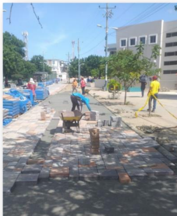
Gráfico 60: Adoquinado peatonal -obras del sistema hidrosanitario y soterramiento
