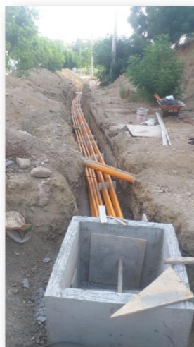
Gráfico 61: Obras civiles soterramiento fibra óptica y eléctrica
