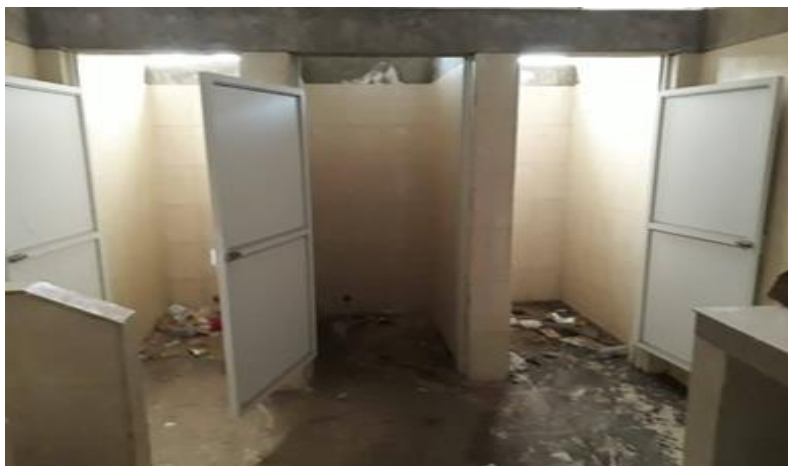
Gráfico 38: Mantenimiento baterías sanitarias Fuente: Dirección de Infraestructura, Obras y Patrimonio
