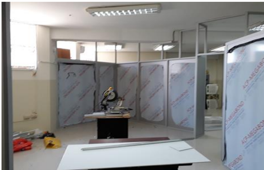
Gráfico 34: Adecuaciones oficinas decanato de Arquitectura Fuente: Dirección de Infraestructura, Obras y Patrimonio
