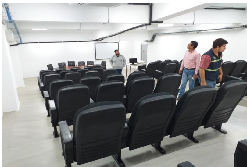
Gráfico 39: Remodelación áreas administrativas (Secretaría General) Edificio Parqueadero Fuente: Dirección de Infraestructura, Obras y Patrimonio
