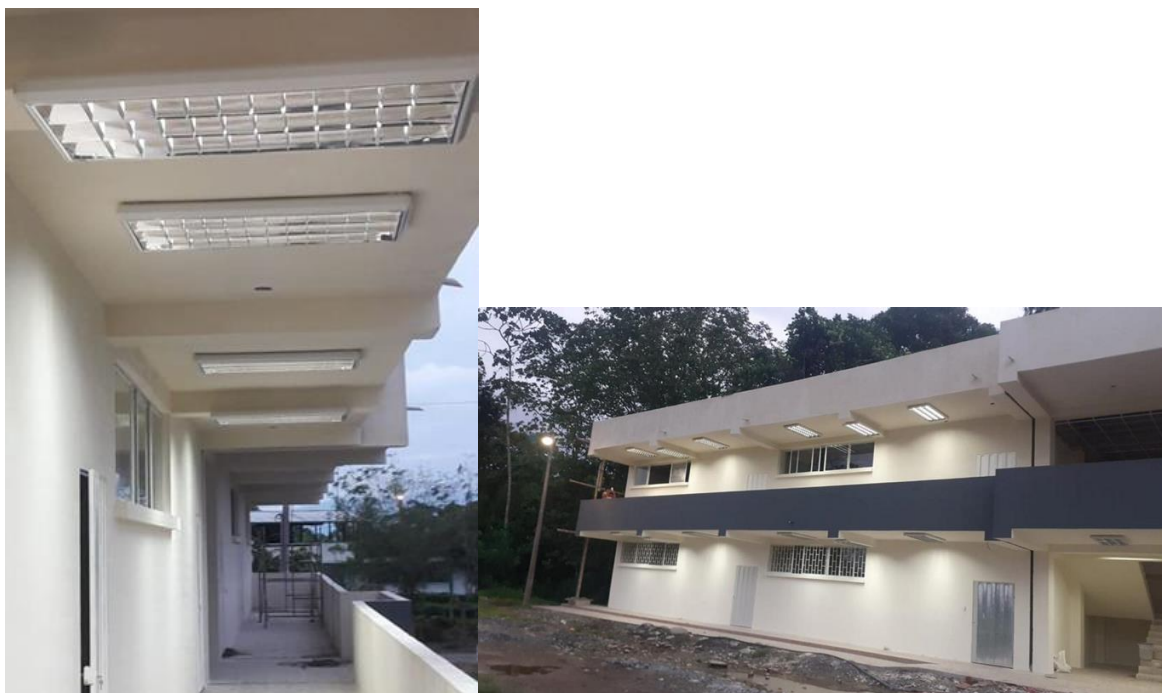
Gráfico 36: Construcción de aulas Extensión El Carmen Fuente: Dirección de Infraestructura, Obras y Patrimonio
