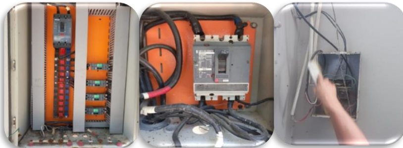
Gráfico 45: Revisión de energía en ajuste y limpieza de breaker
