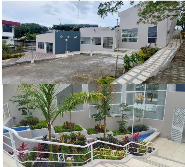
Gráfico 45: Remodelación del Edificio del Instituto de Idiomas Uleam Matriz
