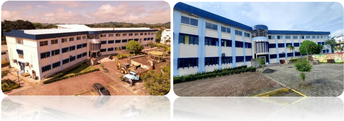
Gráfico 44: Construcción de la Tercera Planta del Bloque B Extensión Chone Uleam
