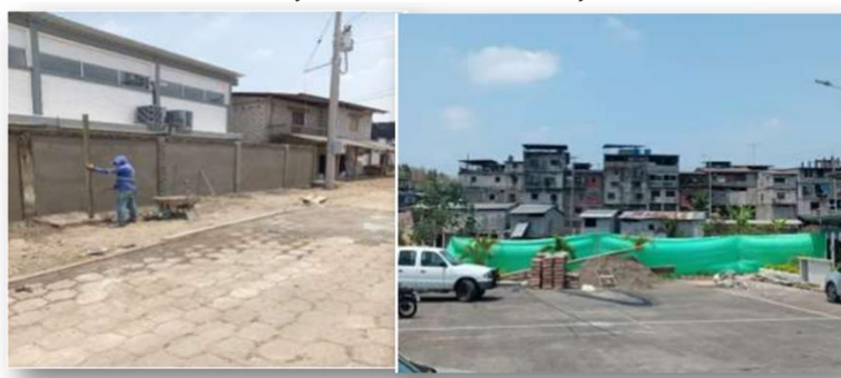
Gráfico 52: Ejecución de la segunda fase de construcción del campus Pichincha: cerramiento, construcción y adecuación del bar y restaurante.
